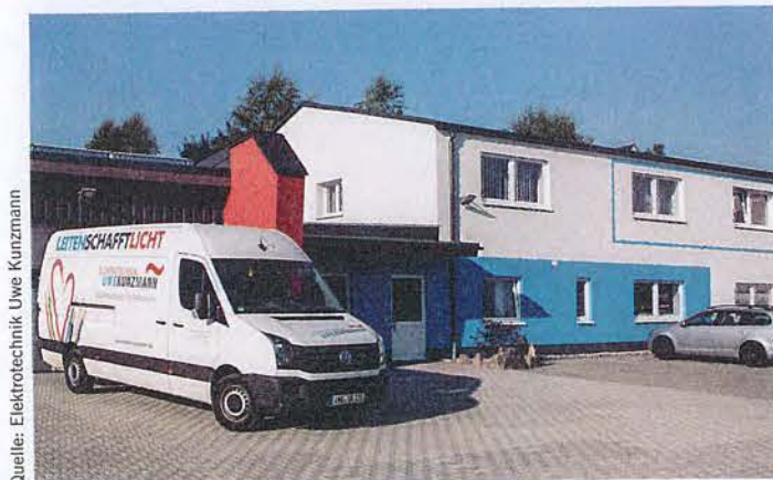
Bild 1: Das Firmengebäude von Elektro-Kunzmann wurde auf den aktuellen Stand der Energie- und Gebäudetechnik hin saniert
