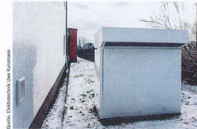
Bild 3: Eine Luft/Wasser-Wärmepumpe mit Vorrangsschaltung nutzt PV-Strom, wenn genau vorgegebene Kriterien erfüllt sind
